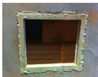
**Figura 3.10 Isolante entre a moldura e a parede**
