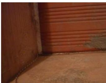
Figura 3.12 Pormenor do poliestireno expandido nas laterais e folha de espuma de polietileno na base com passagem de termopar
