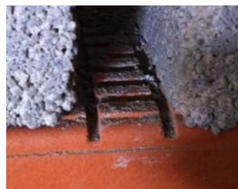
Figura 3.53 Pormenor dos cortes até ao tijolo.
